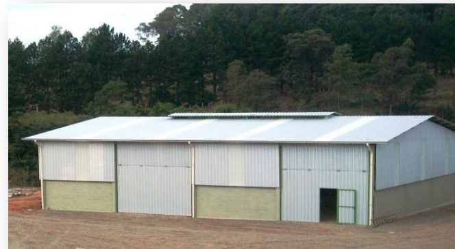
UT – Unidade de Triagem
